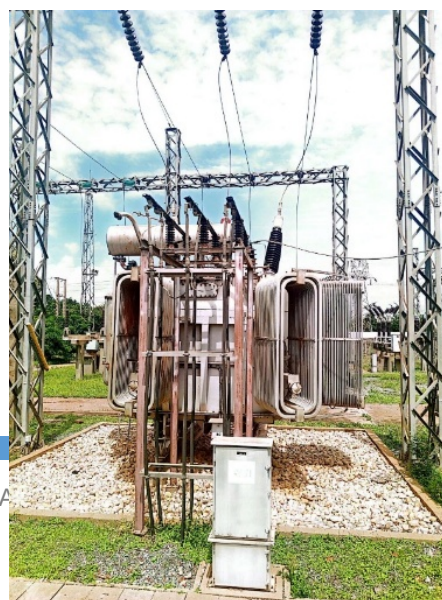
Transformateurs 225/90/15kV-60*3 MVA de Logbaba
