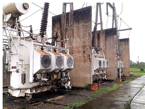
Transformateurs 225/90/15kV-60*3 MVA de Logbaba
