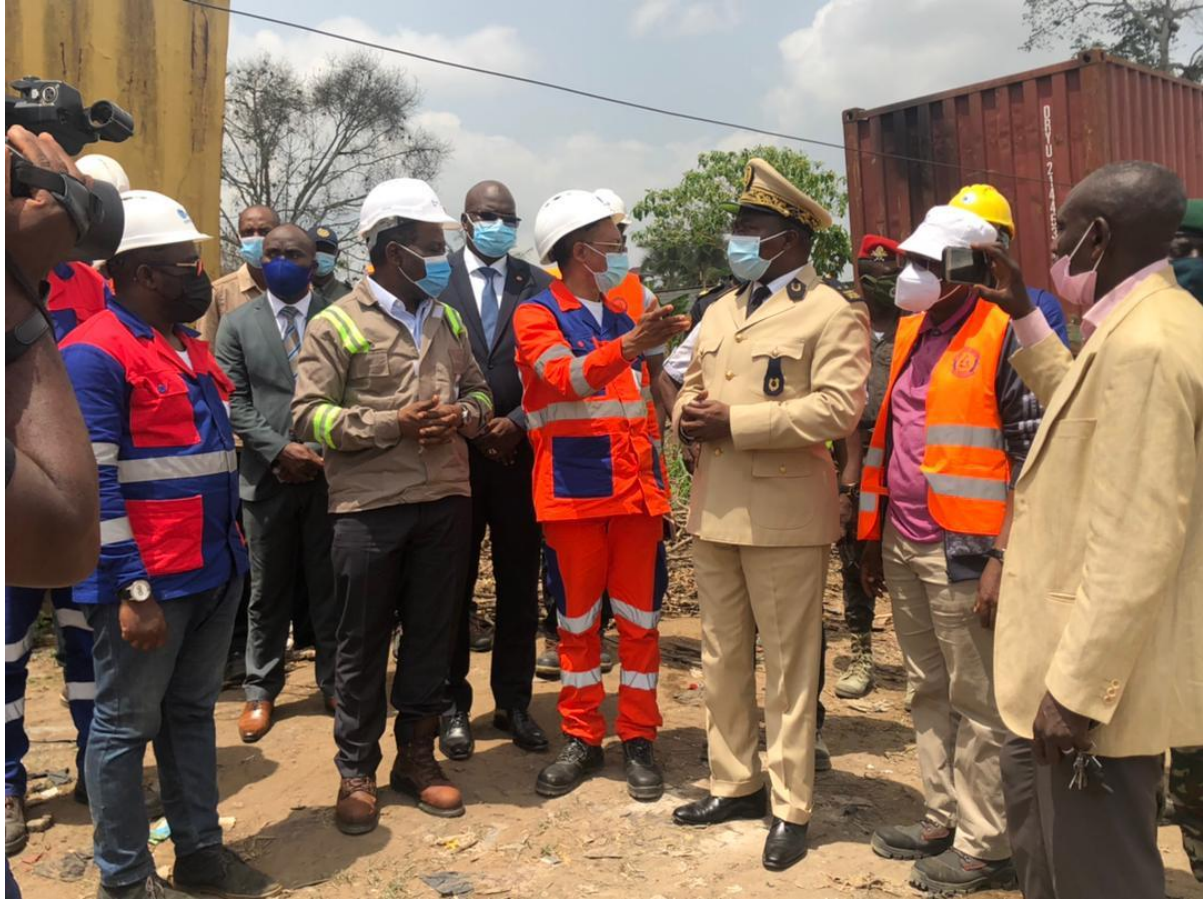
Figure 20 : Visite d'inspection de monsieur le ministre de l'eau et de l'énergie sur les travaux d'élagage des corridors des lignes du RIS
