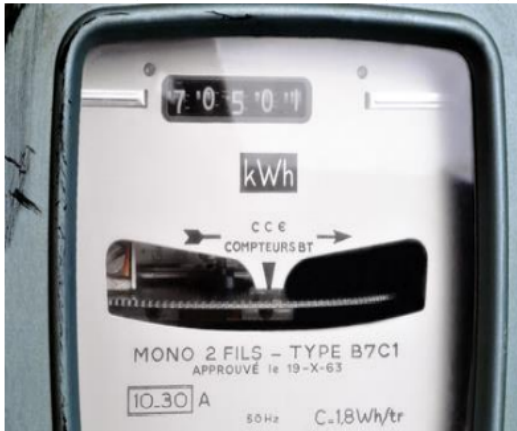
Figure 11: Compteur électromécanique monophasé
