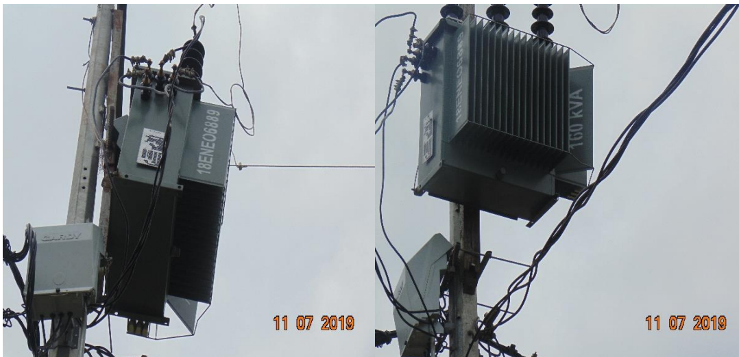
Figure 4: Transformateur H69/160 KVA installé à KEDIA
