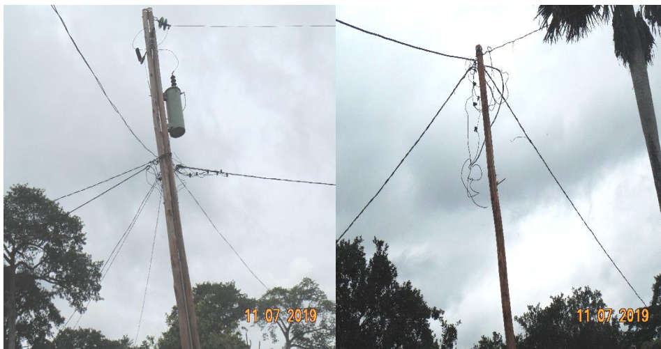
Figure 8: Réseau de distribution monophasé du village Yoro
