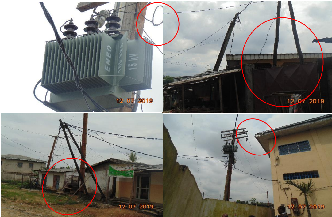
Figure 9: Situations dangereuses constatées sur le terrain
