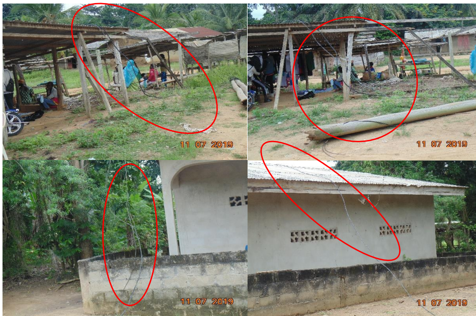
Figure 7: Situations dangereuses constatées sur le terrain
