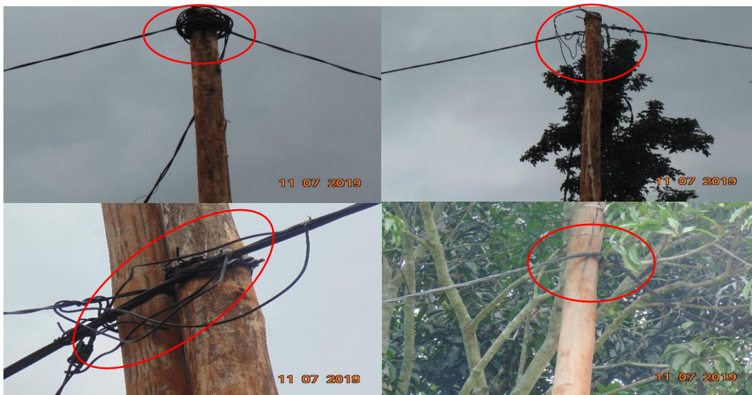
Figure 5: Etat du réseau de distribution après le passage des équipes techniques
