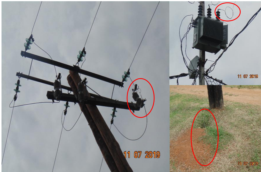
Figure 6: Etat du réseau de distribution après le passage des équipes techniques
