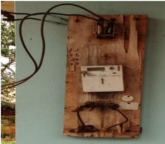
➤ la non normalisation des PL bien qu'ils soient pris en compte dans la facturation de l'opérateur et l'absence des protections (fusible et disjoncteur différentiel) exposant les usagers aux risques d'électrocution ou d'électrisation.
